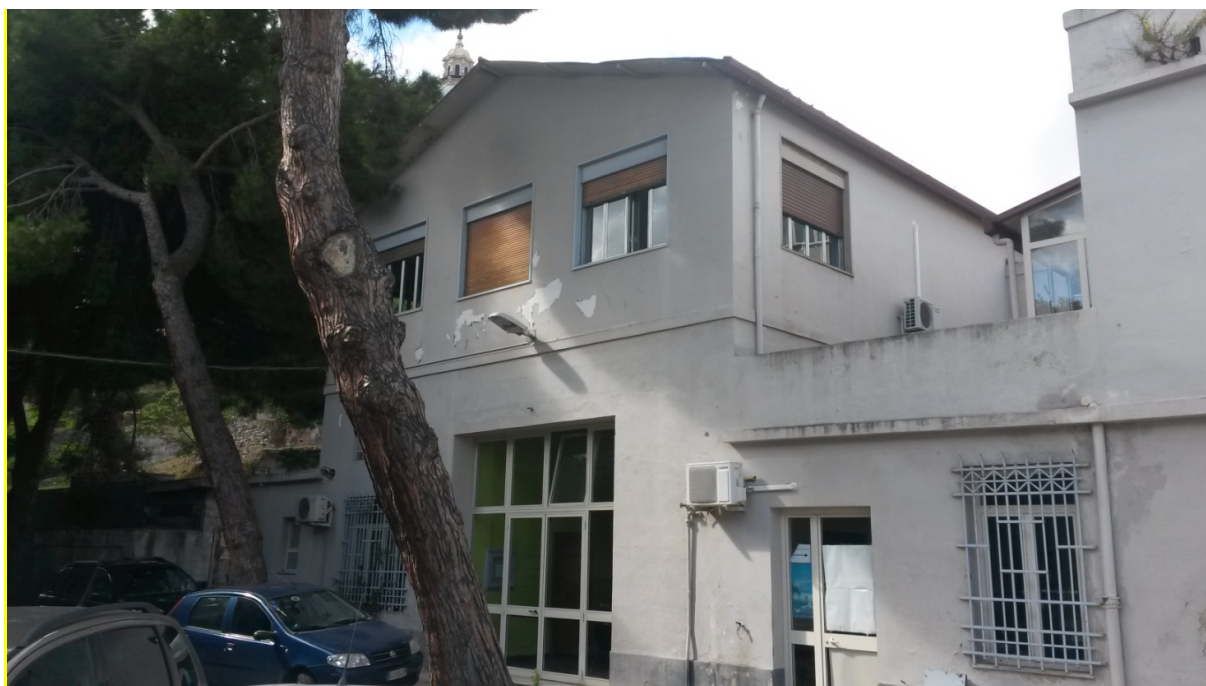
Figura 4 - Edificio "ex Lavanderia"
